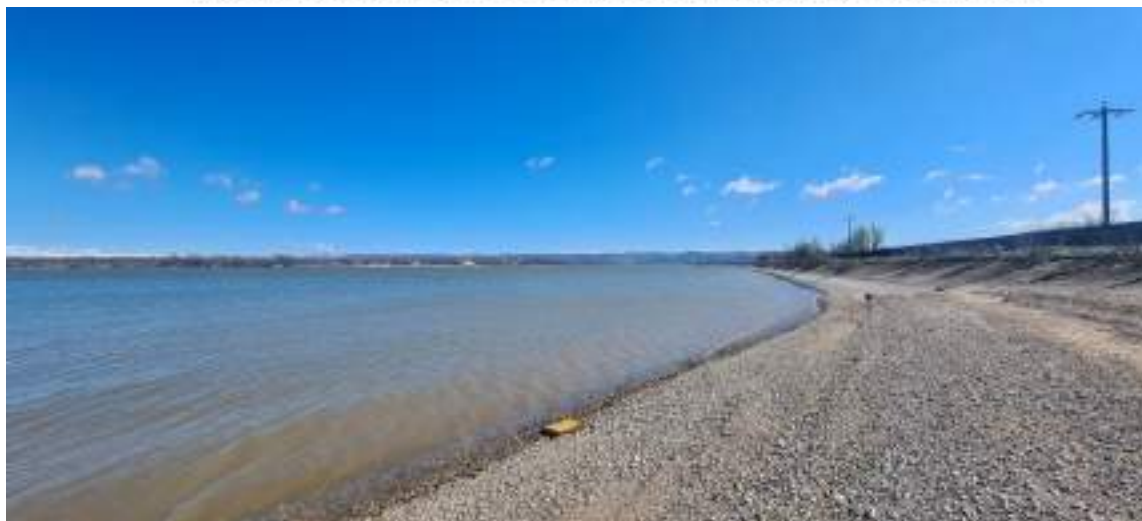
Fig. 83. Taluzul drumului DN56B la Dunărea Mică
